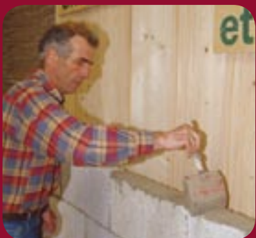
BRIQUES DE CHANVRE ET DE CHAUX - Olivier DUPORT n'hésite pas à nous faire une démonstration.
